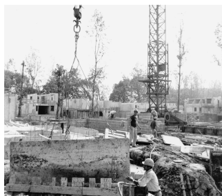
► Le chantier des Béalières
