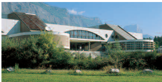
▸ La vue actuelle du bâtiment
